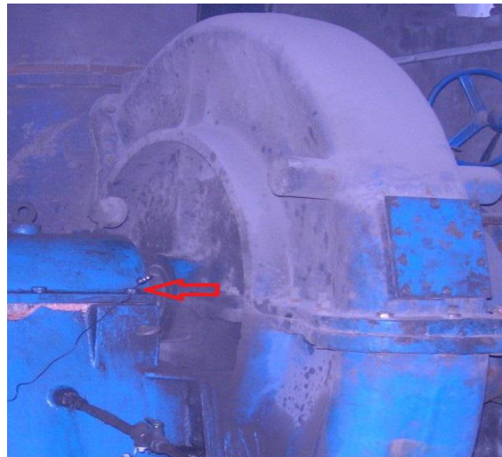
1#除尘风机/2#除尘风机
