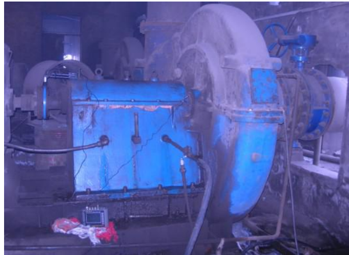
1#除尘风机/2#除尘风机
